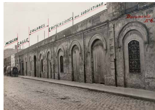
Façana de l'Hospital del carrer de la Rutlla. Fot. Tort. ACAE.
