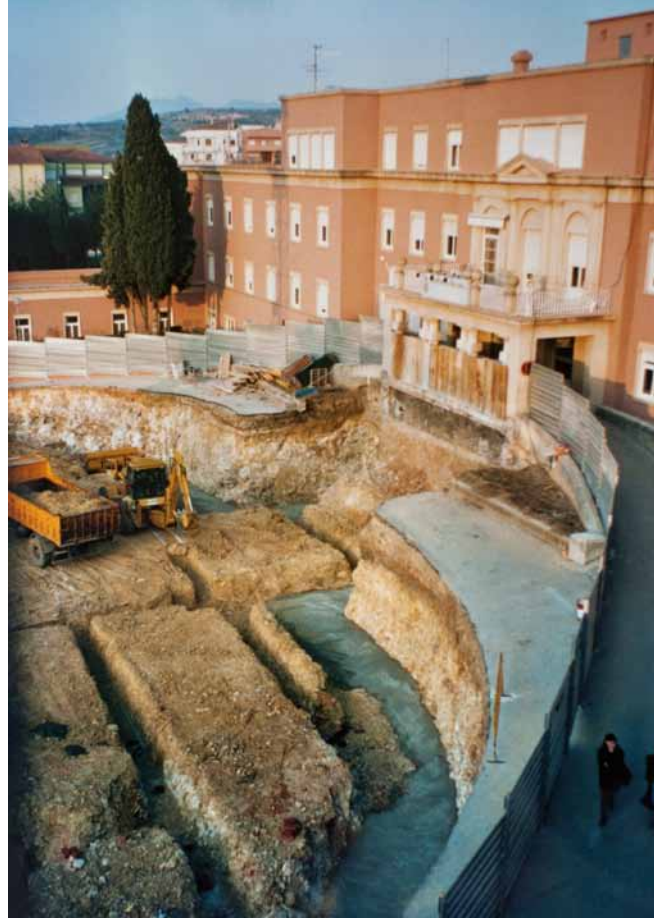
Obres d’ampliació de l’àrea quirúrgica.
