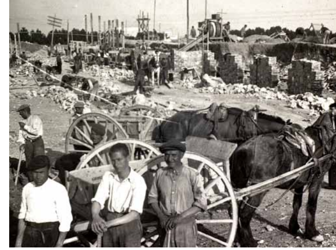
Obrers durant els treballs de construcció. AMF, Fons Godoy.
