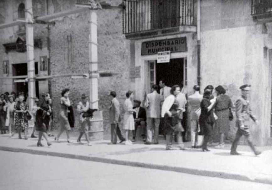
Durant la postguerra s'instal·là un dispensari a la casa del capellà, que fou utilitzat en la votació del referèndum de 1947. Arxiu particular Jordi Bonaterra.
